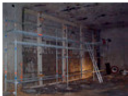
Construction d'un mur de fermeture (RD4)
