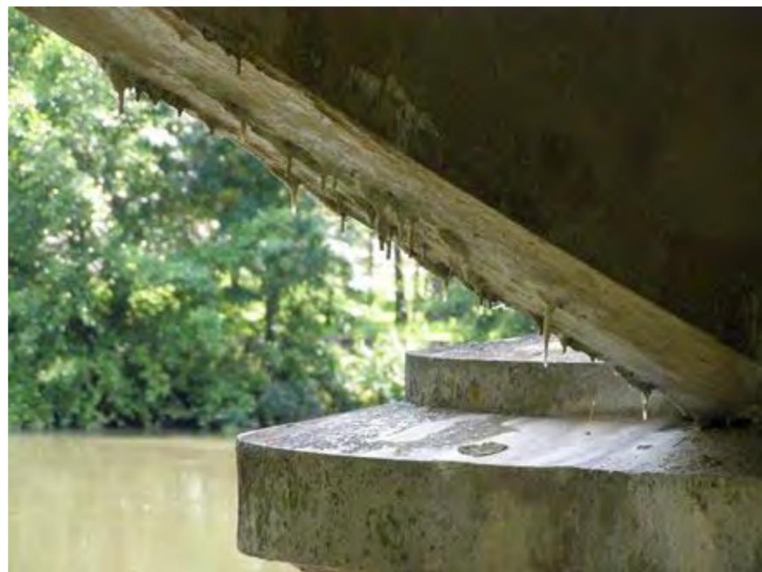
Présence de calcite sur les poutres de rives du tablier
