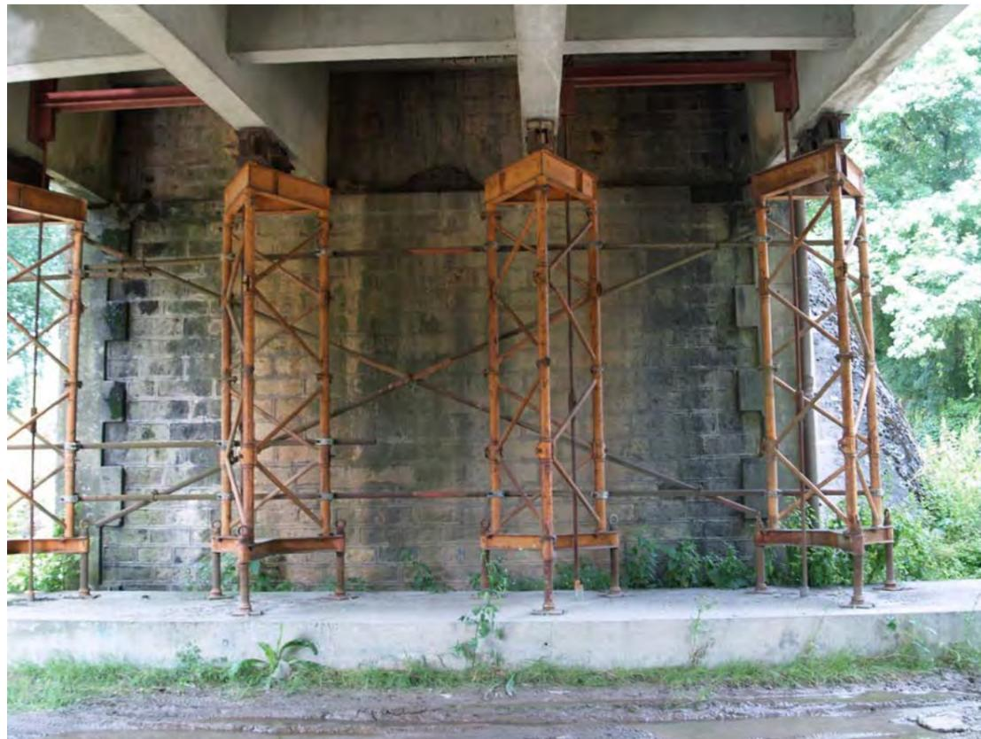
Etaisements et dispositif de stabilisation de la culée rive droite
