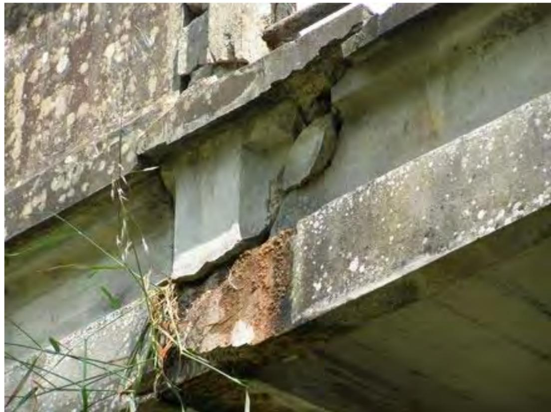
Fracture importante de l'encorbellement du tablier au droit de la culée
