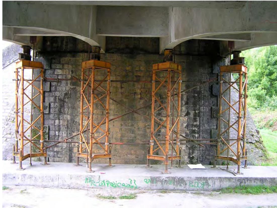
Etaisements et dispositif de stabilisation de la culée rive gauche
