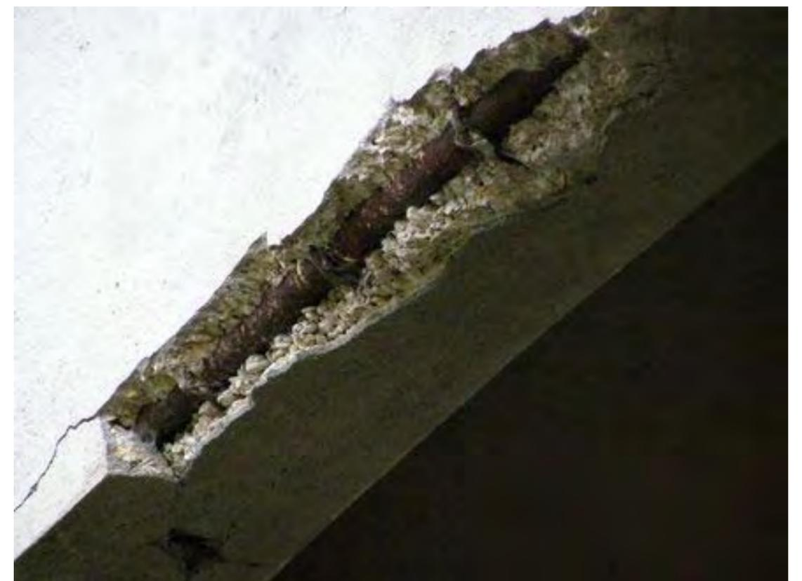
Béton fracturé sur une poutre avec aciers apparents corrodés
