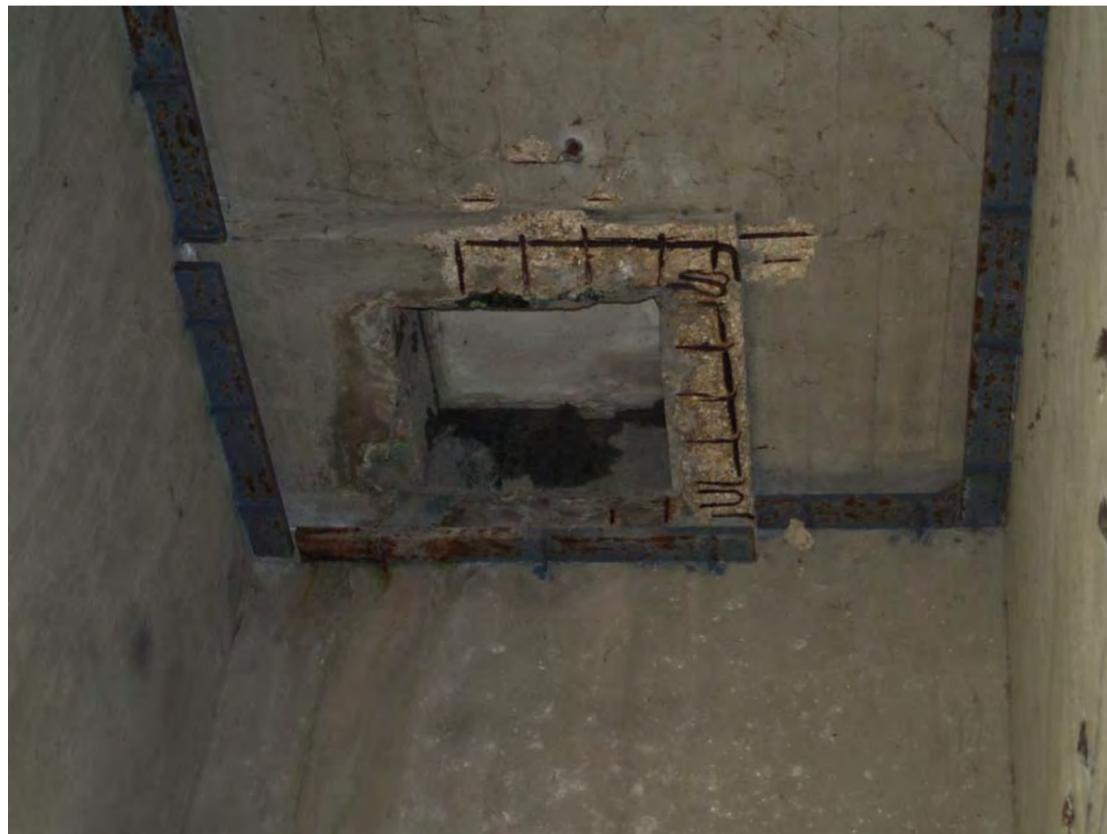
Béton fracturé du hourdis du tablier avec aciers apparents corrodés
