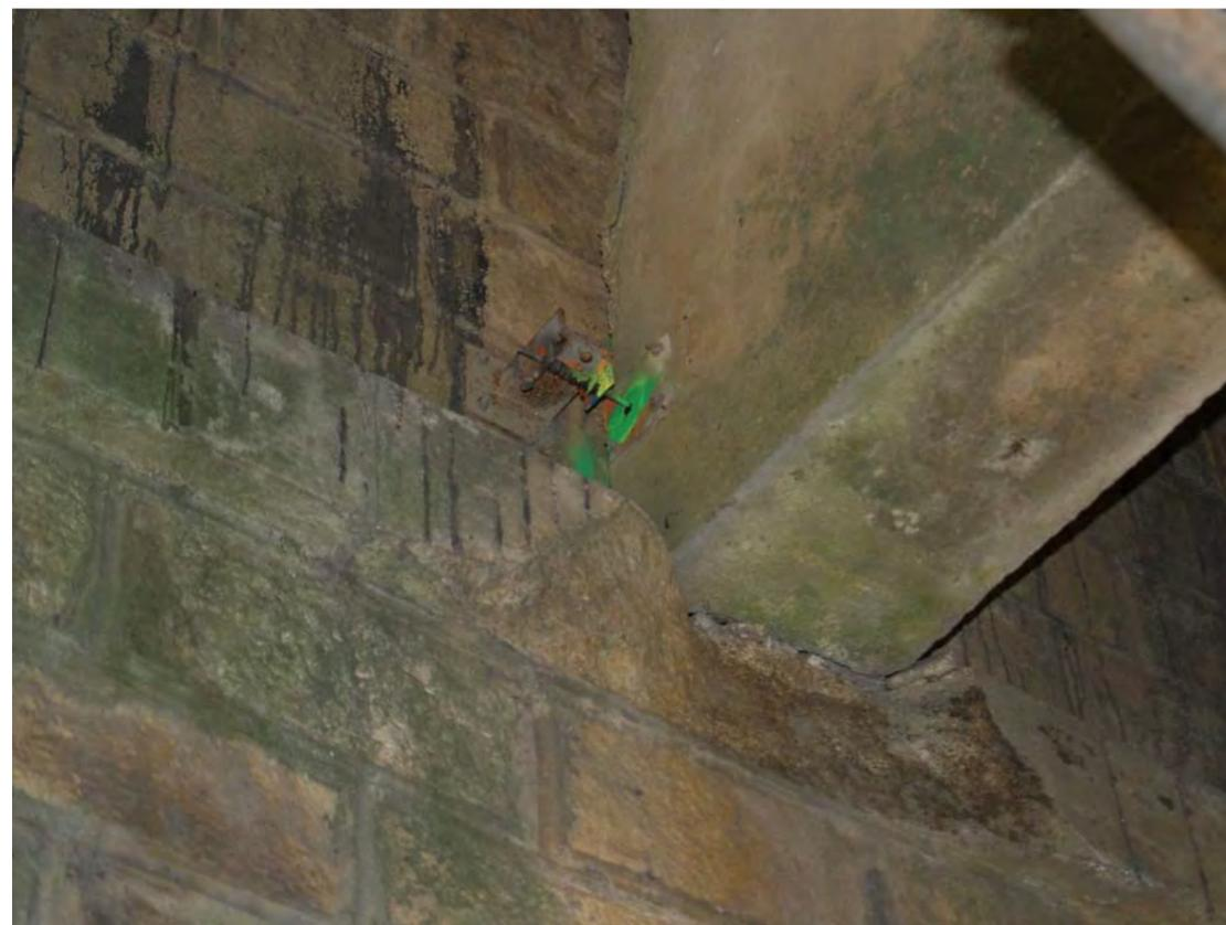
Dispositif de contrôle de soulèvement des culées
