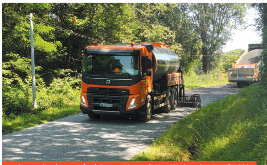
Application d'enduit superficiel d'usure (ESU) sur la RD 110 à Saint-Sornin, juillet 2024
